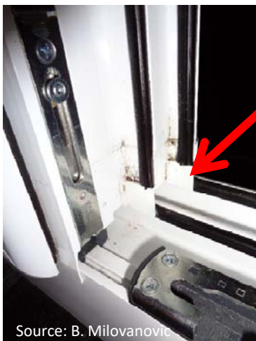
Rast gljivica zbog prekida brtve
