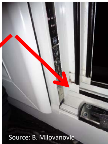
Rast gljivica zbog prekida brtve
