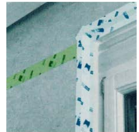
nepropusne reške (fuge) kod otvora OBRAĐENI DETALJI
