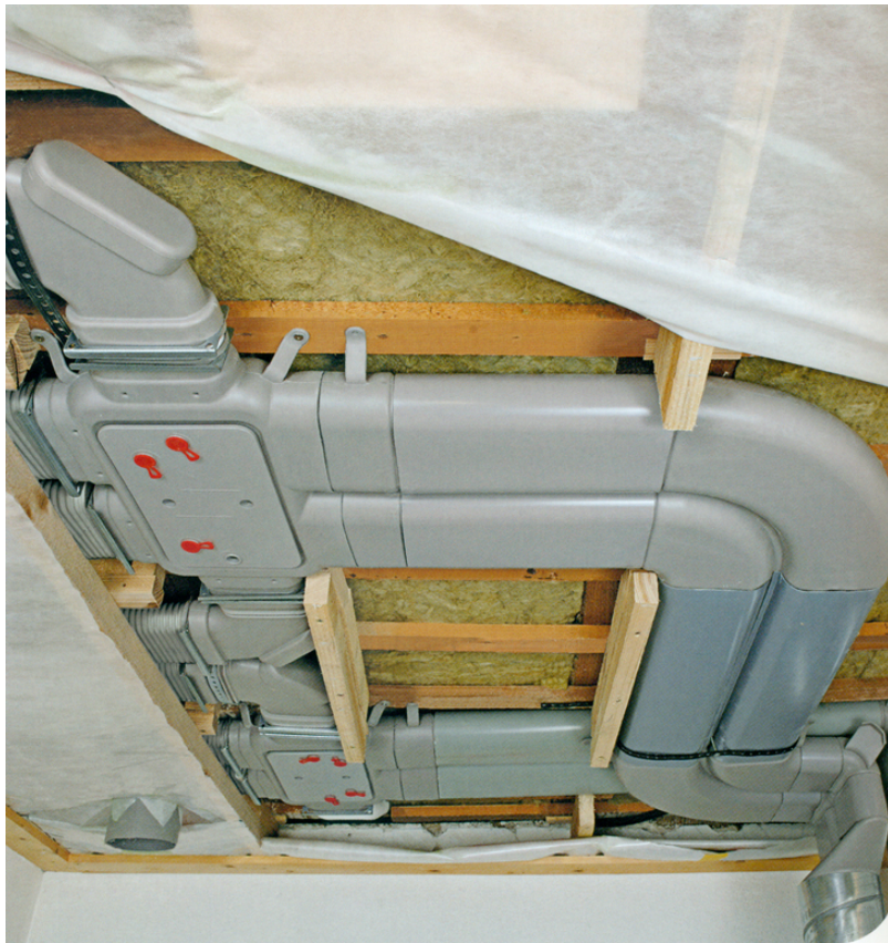
montaža u ovješeni strop
