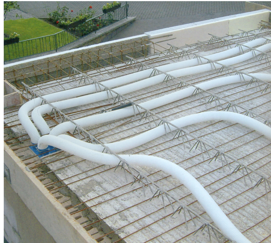
montaža u stropnu ploču (~ „OMNIA” ploča)
