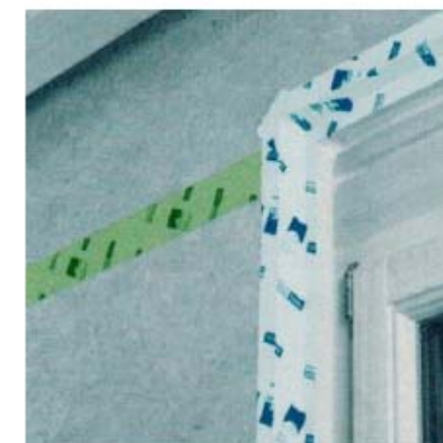
nepropusne reške (fuge) kod otvora OBRAĐENI DETALJI
