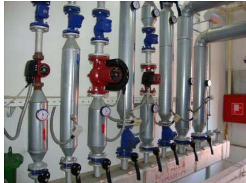
polazni i povratni razdjeljivač (ili razdjelnik i sabirnik)
